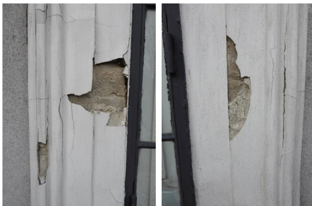
Zniszczenia i odkrywki opaski niszy dolnej w elewacji wschodniej.
