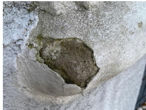
W odkrywkach cokołu analogiczny układ warstw. Wykonane nawierty w przyziemi elewacji.
