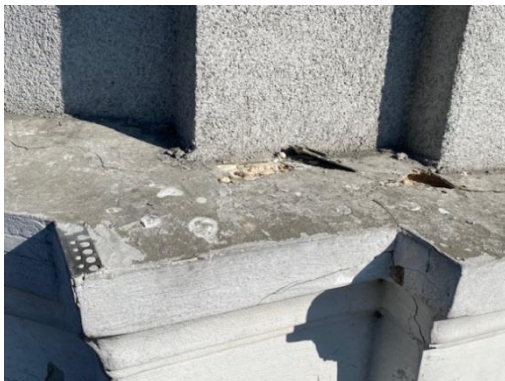
Spękania i odspojenia tynku. Użyte profile aluminiowe.
