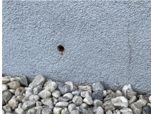
W odkrywkach cokołu analogiczny układ warstw. Wykonane nawierty w przyziemi elewacji.
