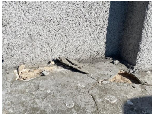
Spękania i odspojenia tynku. Użyte profile aluminiowe.
