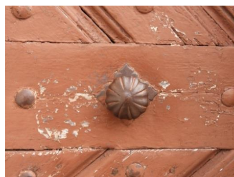
Zniszczenia wtórnej stolarki drzwiowej.
