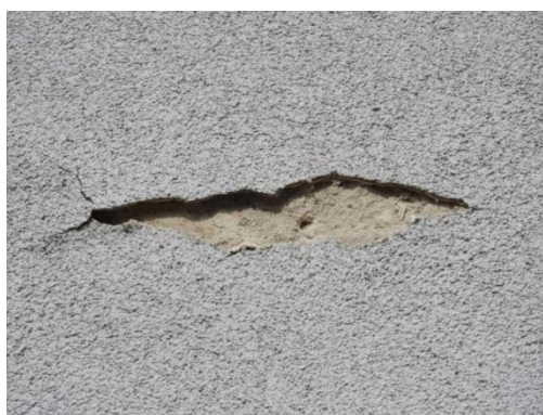
Spękania, rozwarstwienia tynków elewacji. Na elewacji siatka budowlana.
