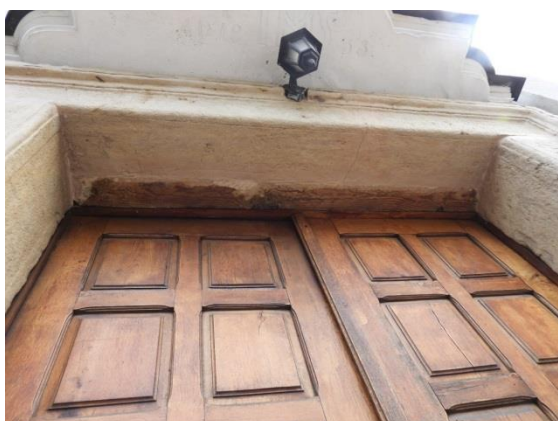
Zniszczenia wtórnej stolarki drzwiowej.
