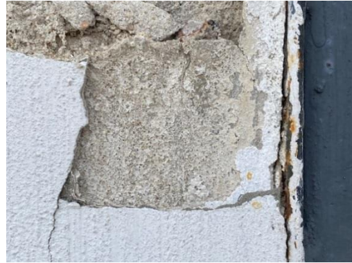
Odkrywki opaski niszy dolnej w elewacji wschodniej. Jasna kolorystyka ciepłej bieli na tynku.
