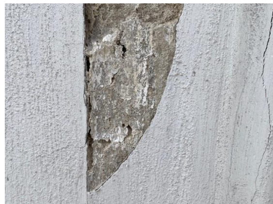
Zniszczenia i odkrywki opaski niszy dolnej w elewacji wschodniej.
