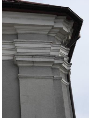
Zacieki, czarny nalot, spękania i rozwarstwienia, ubytki w partiach detalu architektonicznego.
