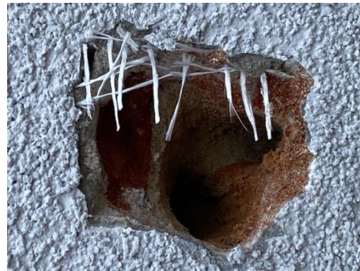
Odkrywki opaski niszy dolnej w elewacji wschodniej. Jasna kolorystyka ciepłej bieli na tynku.
