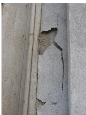
Spękania, rozwarstwienia tynków elewacji. Na elewacji siatka budowlana.
