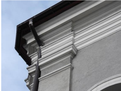
Zacieki, czarny nalot, spękania i rozwarstwienia, ubytki w partiach detalu architektonicznego.
