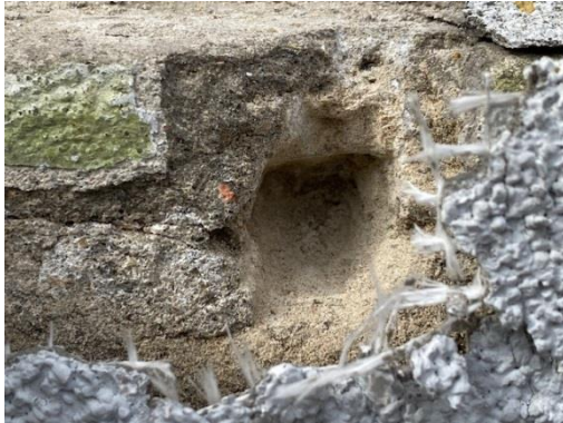
W odkrywkach cokołu analogiczny układ warstw. Wykonane nawierty w przyziemi elewacji.
