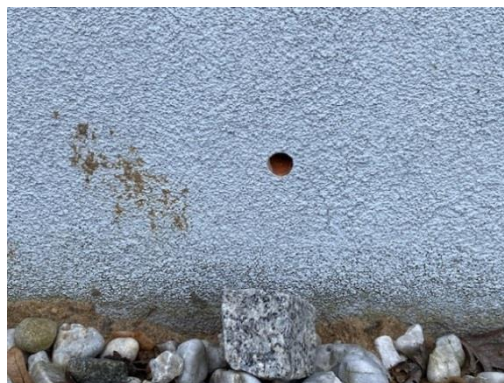
Odkrywki ściany wschodniej zakrystii i kolejny zaobserwowany odwiert w przyziemiu.
