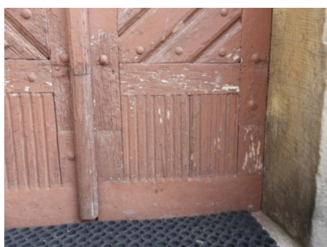
Zniszczenia wtórnej stolarki drzwiowej.
