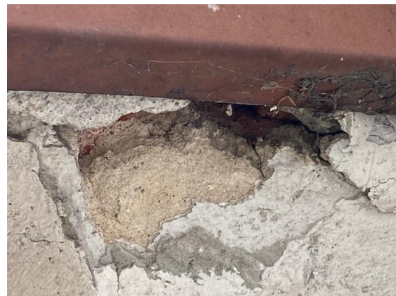
Odkrywki gzymsu pod obróbką blacharską z białymi warstwami wymalowań na najstarszym tynku.
