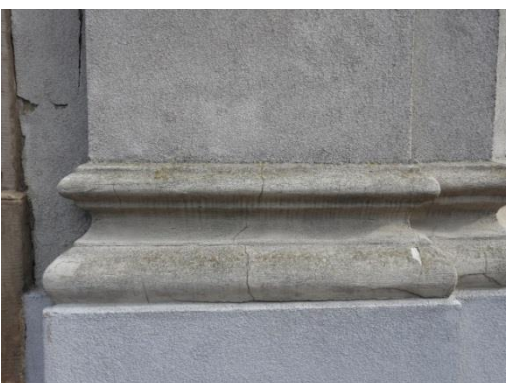
Mikroorganizmy i zabrudzenia na elewacji. Spękania, odspajający się tynk z ubytkami detali architektonicznych.
