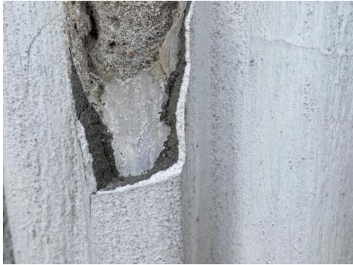
Odkrywki opaski niszy dolnej w elewacji wschodniej. Jasna kolorystyka ciepłej bieli na tynku.
