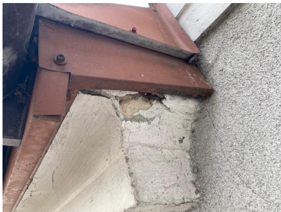
Odkrywki gzymsu pod obróbką blacharską z białymi warstwami wymalowań na najstarszym tynku.
